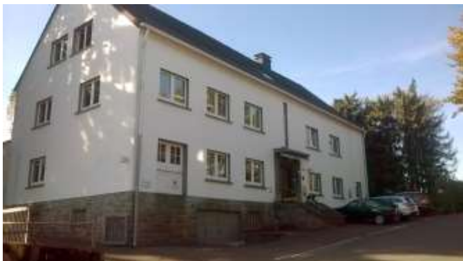
Betriebsgebäude am Heckersklef
