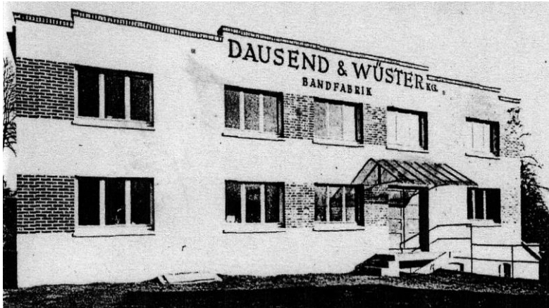
Das ehemalige Fabrikgebäude an der Staubenthaler Straße
