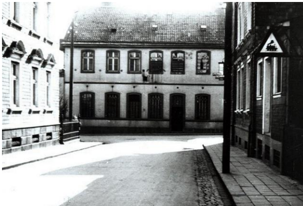
Blick Auf die Färberei Frickenhaus, Kocherstraße
