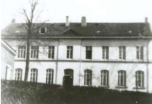
Schulgebäude Holthäuser Str
