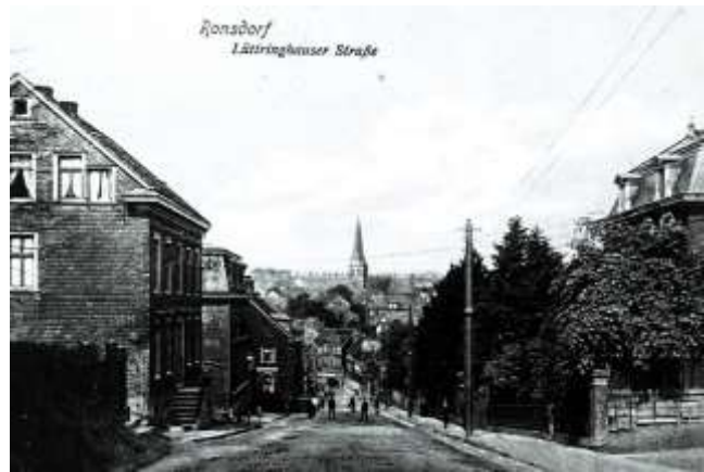
Blick von der Lüttringhauser Straße
