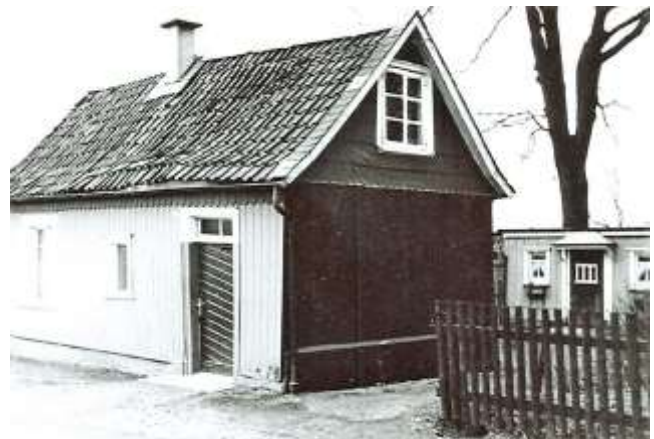
Die „Hütte“ an der Luhnsfelder Höhe heute
