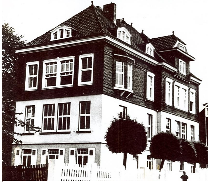
Das 1910 errichtete ehemalige katholische Schulgebäude an der ehemaligen Friedrichstraße heute Lilienstraße
