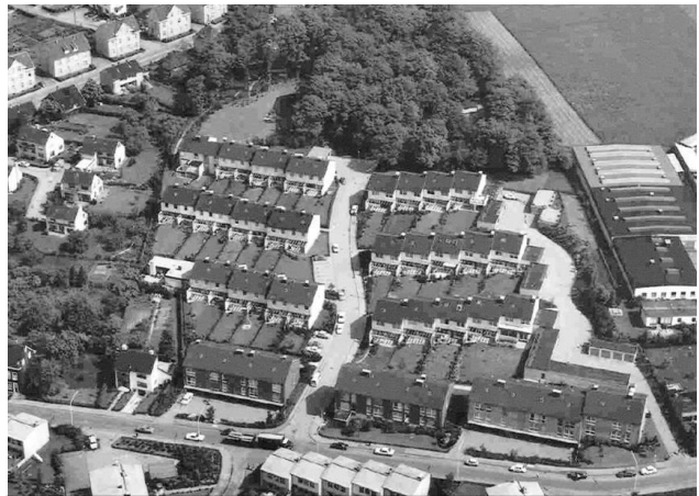
Die Ronsdorfer Neubau-Siedlung Lohsiepen
