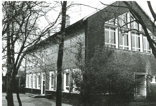
Die Schule nach dem Umbau 1960
