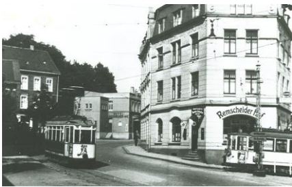
Straßenbahnen an der Gleisschleife Remscheider Str./Am Stadtbahnhof
