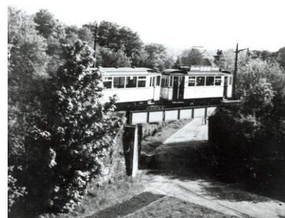
Zug der Linie 23 auf der Brücke In der Krim
