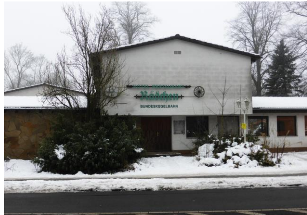
Das 1971 neu erbaute Hotel/Restaurant wurde 2017 abgerissen
