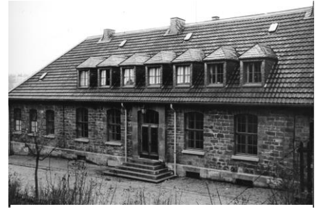
Der heutige Kindergarten an der Bandwikerstraße
