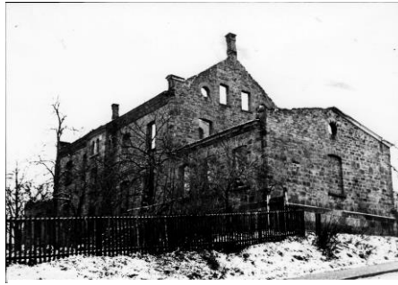
Die Ruine des alten Schulgebäudes an der Bandwikerstraße
