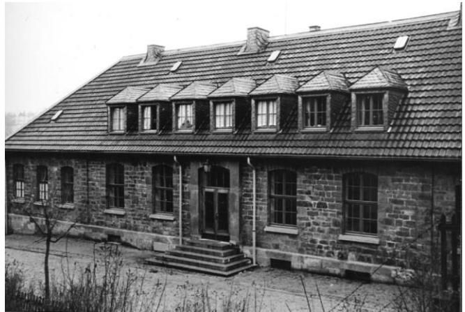
Kindergarten Bandwirkerstraße nach dem Wiederaufbau
