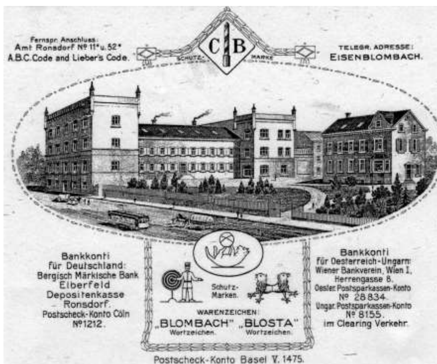
Ehemaliges Geschäftsgebäude der Firma Carl Blombach an der damaligen Franzstraße
