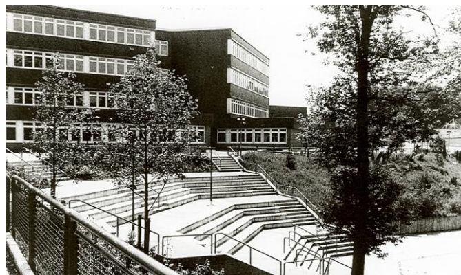
Gesamtschule von der Rückseite
