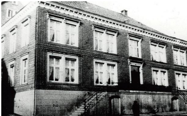
Ehemaliges Geschäftshaus v. Bauer an der Marktstr. 32
