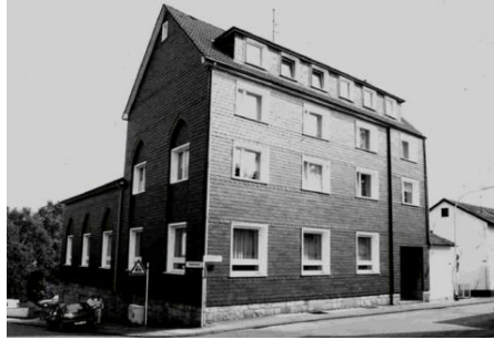
Das Dürselenhaus nach dem Wiederaufbau
