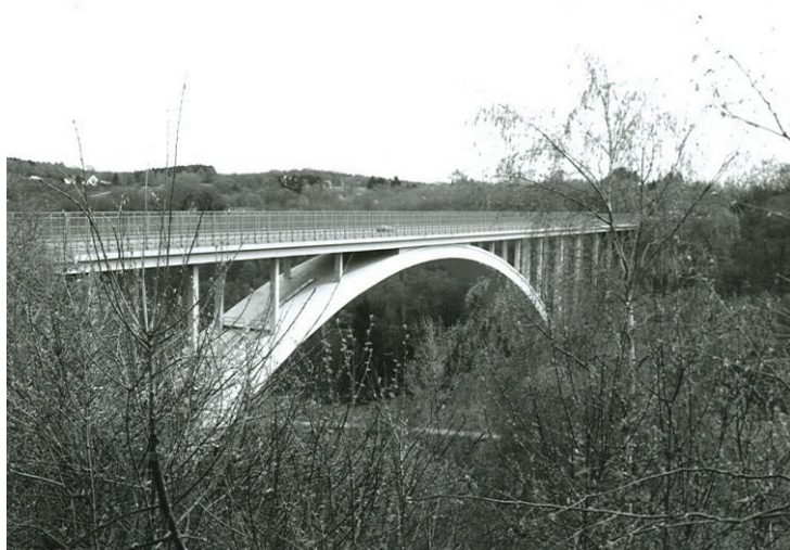
Die heutige Blombachtalbrücke
