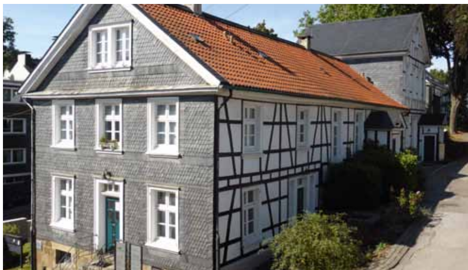
Alte reformierte Schule an der Elias-Eller-Straße 48.
